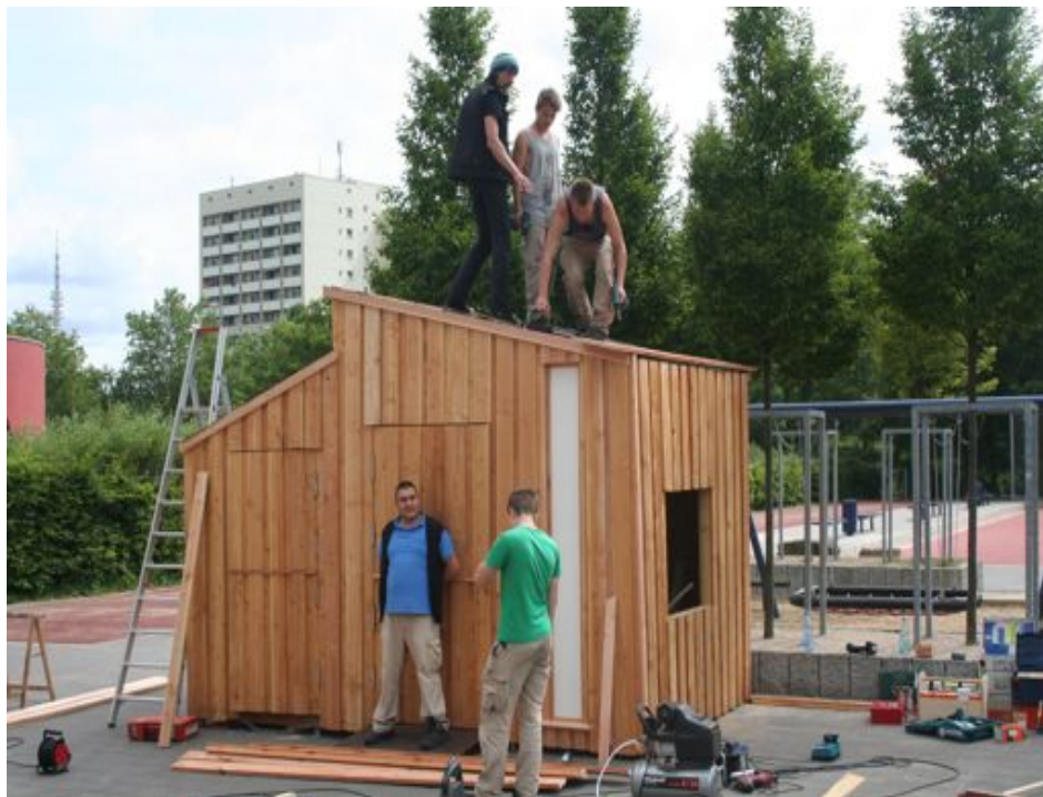
Dieses kleine Holzhaus entsteht auf dem Schulhof. Gebaut wird es von den Schülerinnen und Schülern der Produktionsschule Altona. Im rechten Hausteil wird im kommenden Schuljahr der Raum für die Streitschlichter sein und im linken Hausteil wird es in der Mittagsfreizeit einen Verleih von kleinen Spielgeräten geben.
